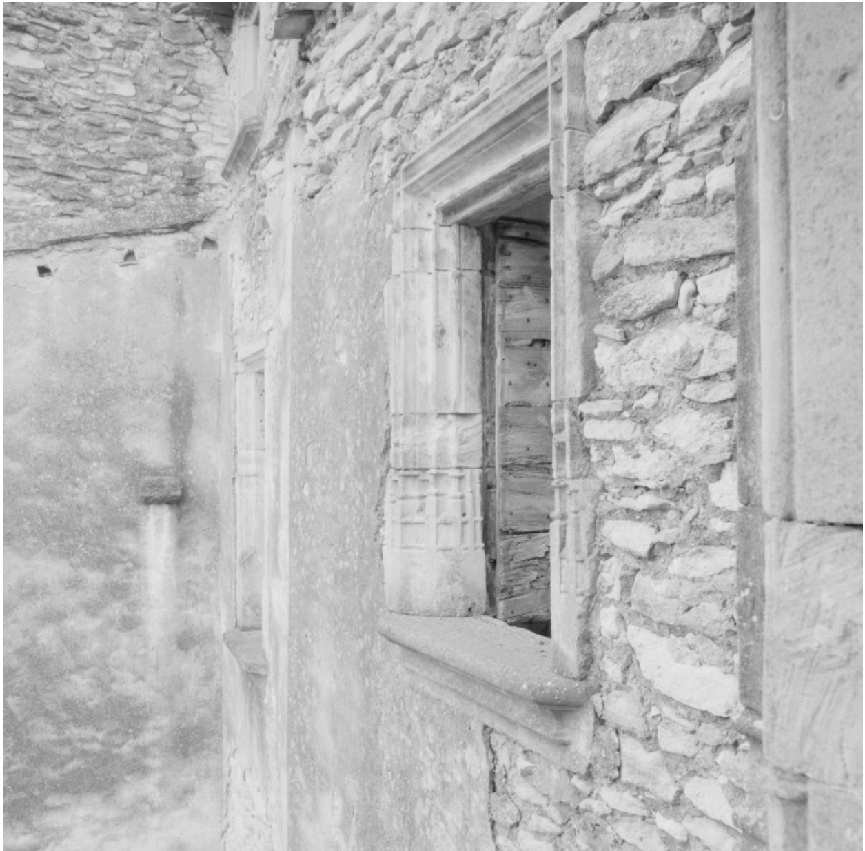
Cour intérieure, corps sud, détail de l'élévation, 3e niveau : encadrement d'une fenêtre anciennement à traverse, à moulures croisées et bases prismatiques.
