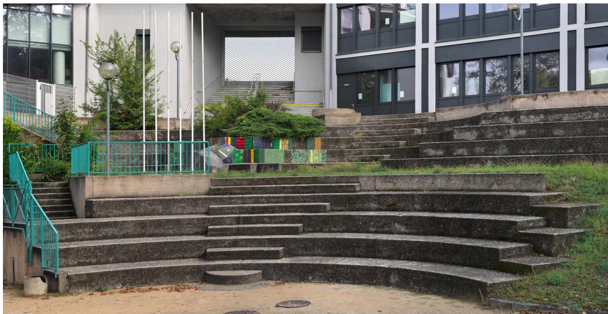
Vue rapprochée des gradins.
