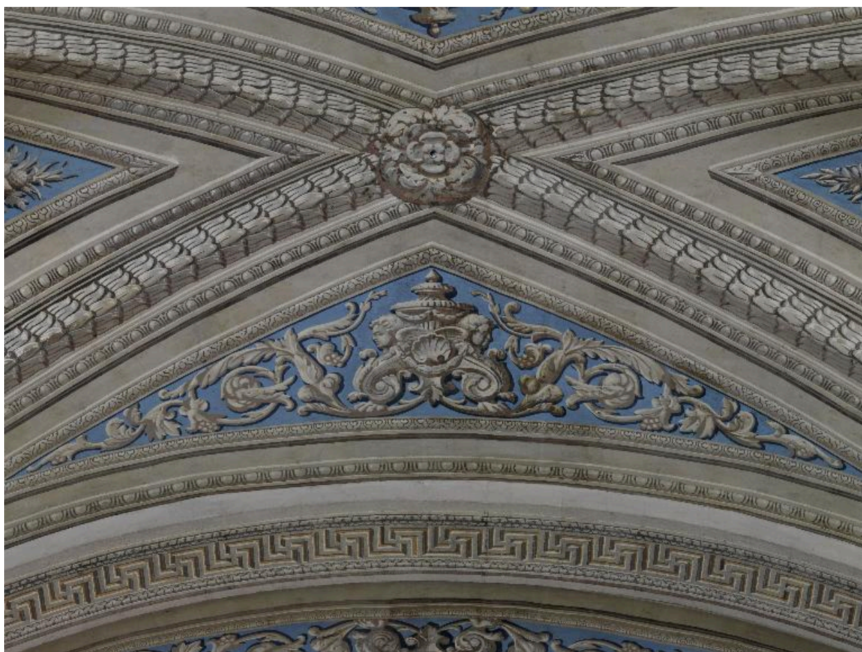
Nef, 2e travée, partie centrale : détail du faux voûtain est
