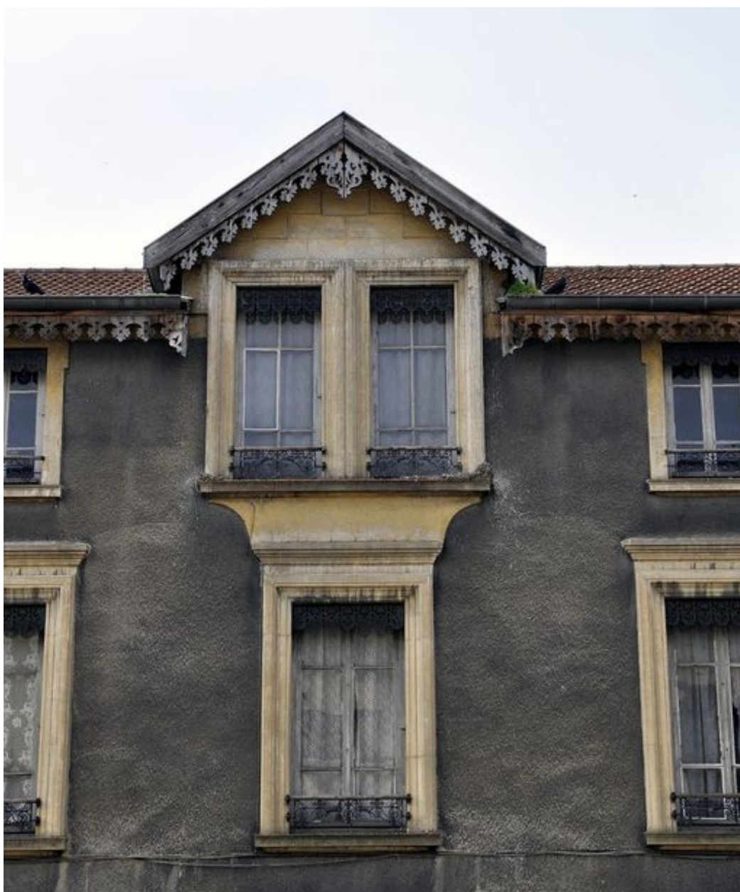
Façade antérieure, travée centrale 2e et 3e étages, baies jumelées
