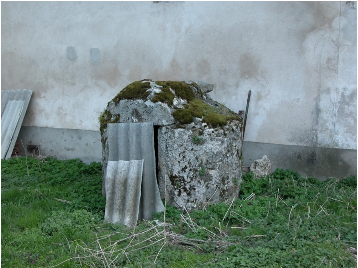
Vue du puits.
