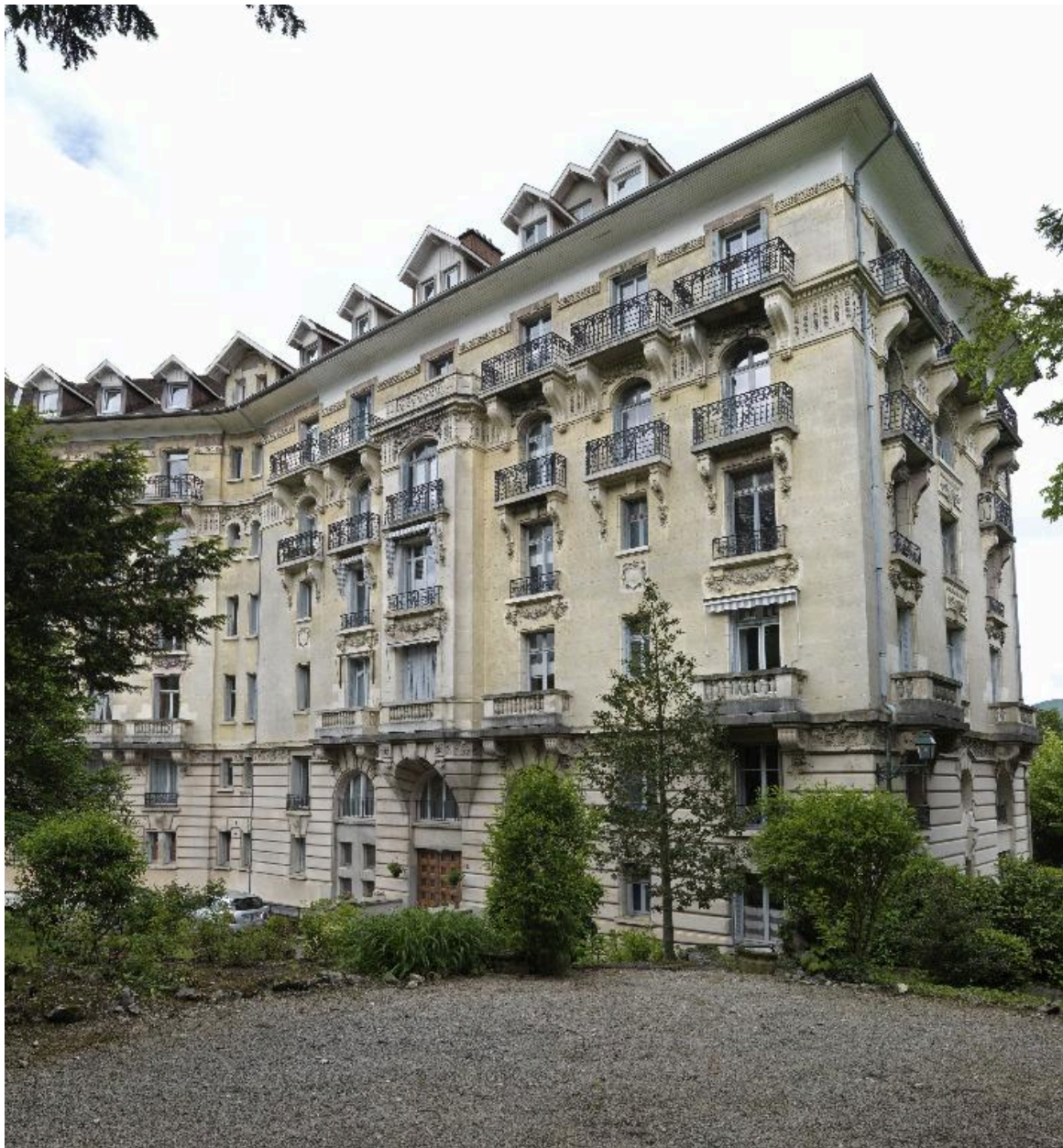
Façade sur cour: aile nord
