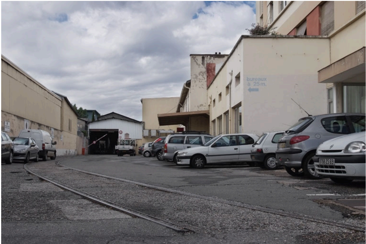
Vue nord, raccordement ferroviaire encore visible
