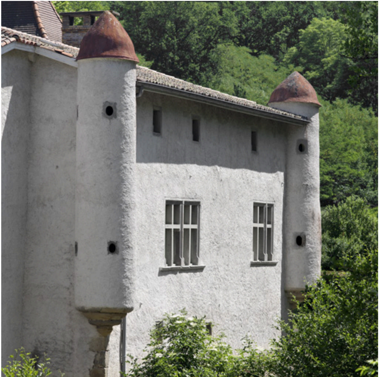
Vue de la façade sud depuis le pont sur le Vizézy, au sud-ouest.
