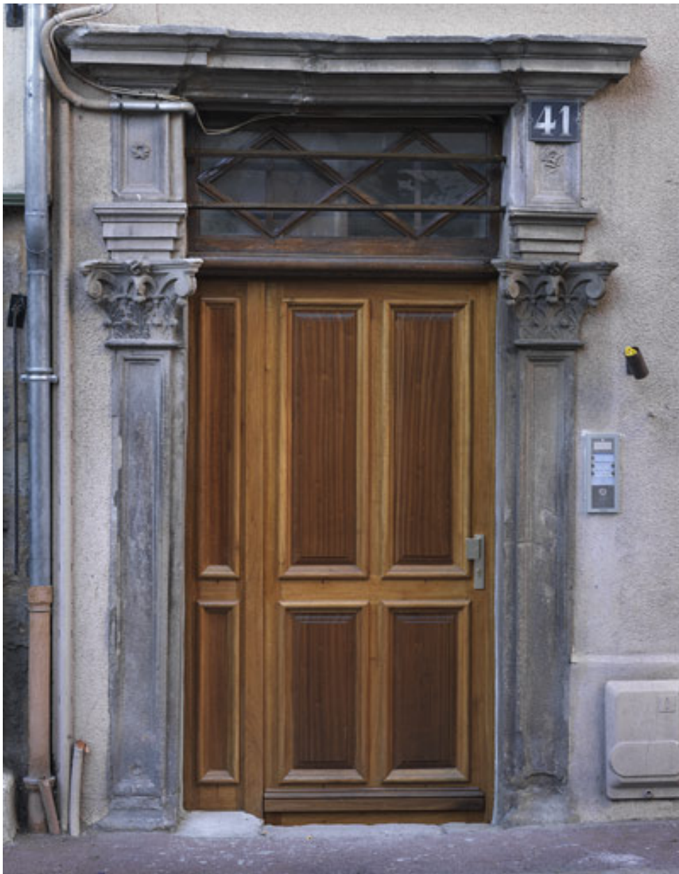
Vue de la porte après travaux exécutés en 2007.
