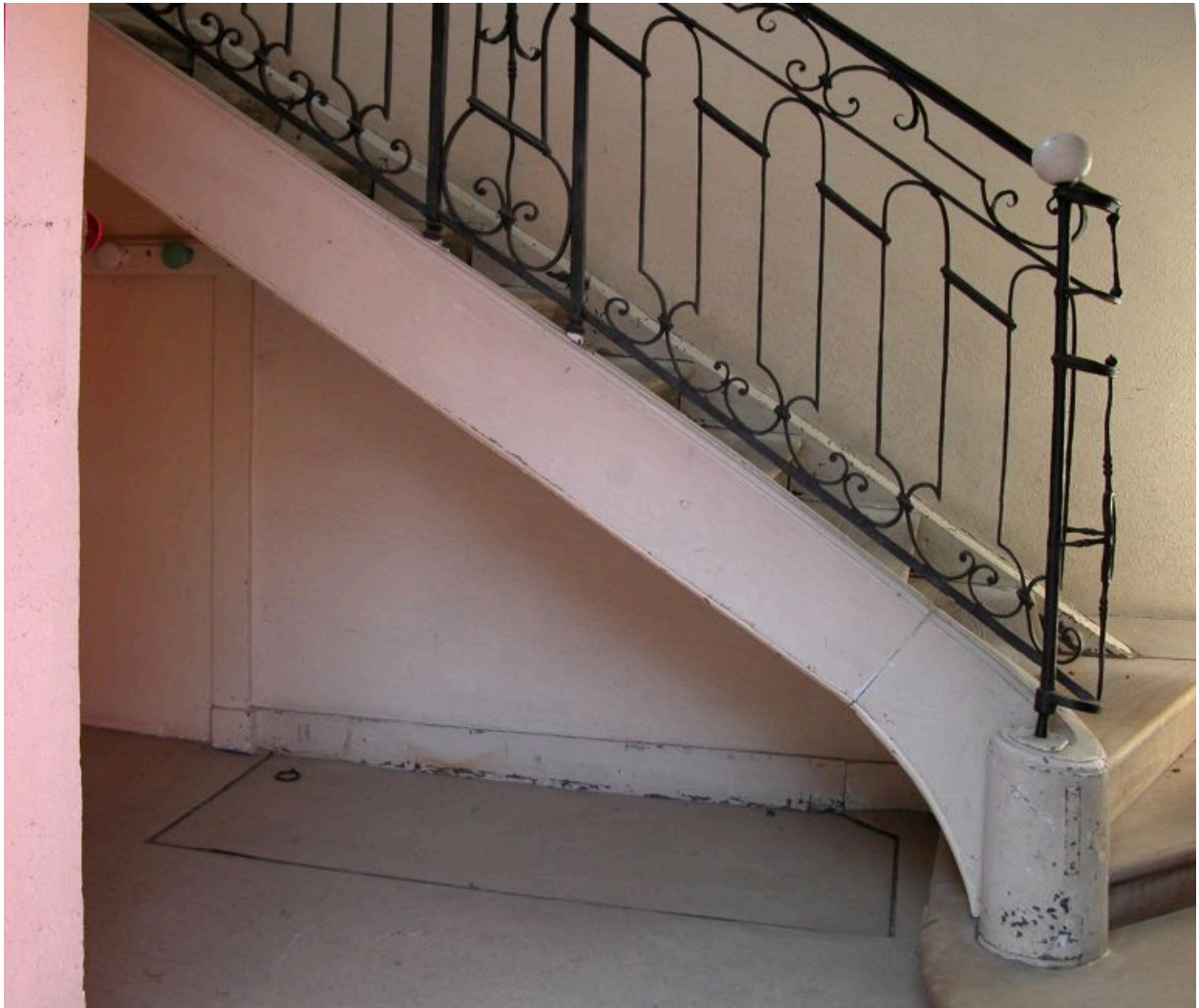
Départ de la rampe d'appui.
