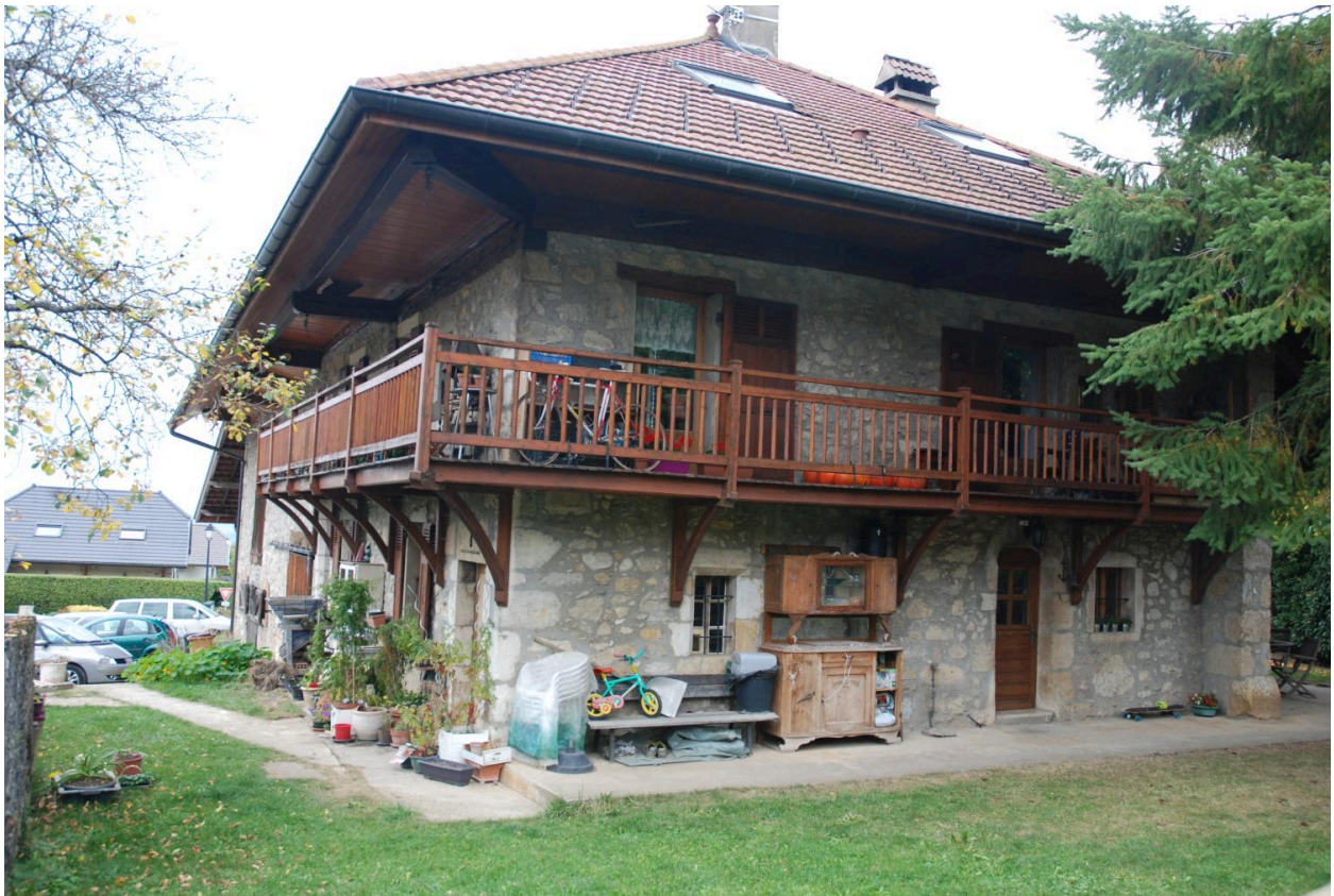
Vue de l'habitation depuis le sud.
