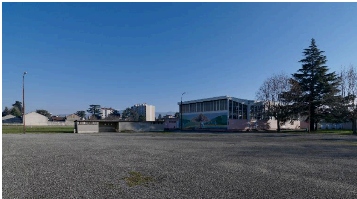
Gymnase et sanitaires extérieurs, depuis le nord-ouest
