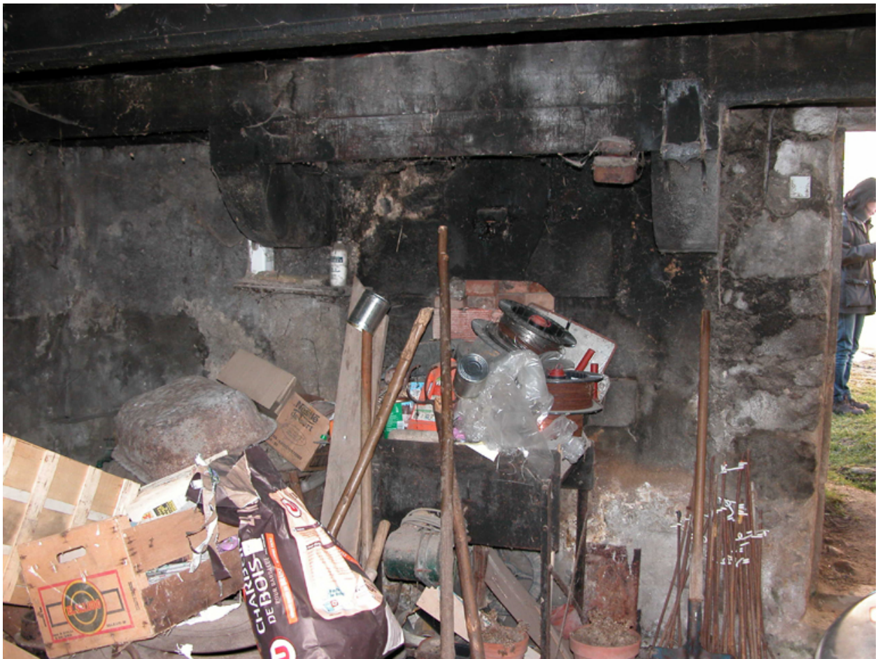
Intérieur du fournil situé dans la cour. Détail de la bouche du four à pain détruit.
