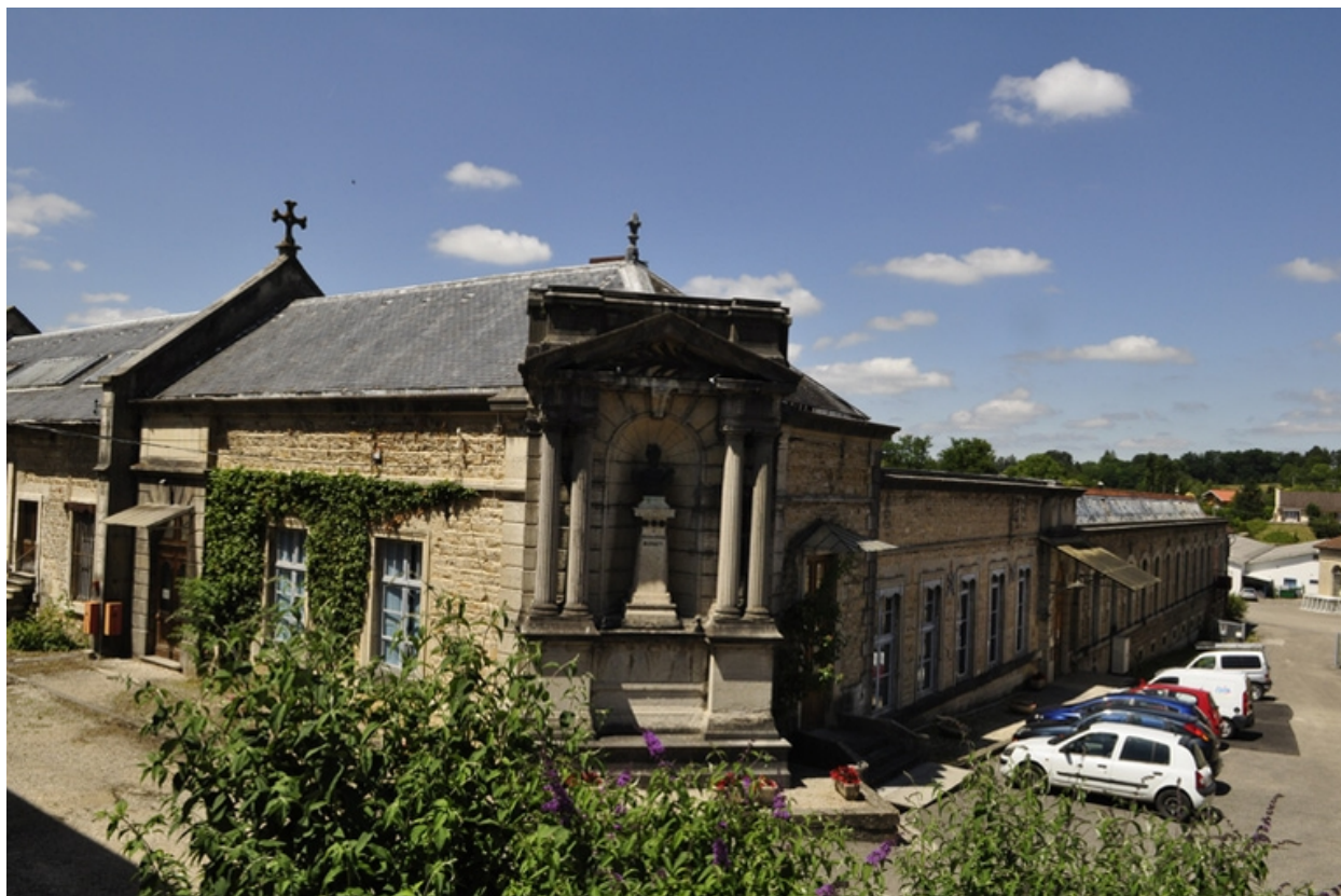
Vue d'ensemble extérieure
