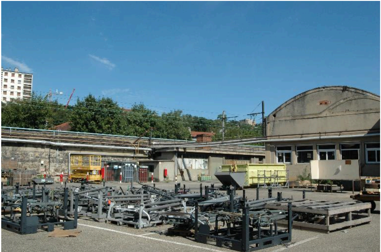
Vue extérieure du site
