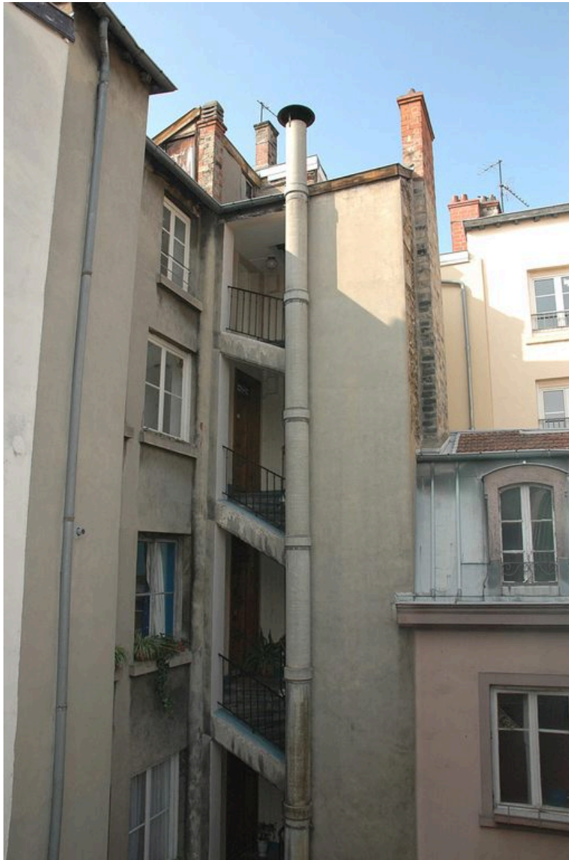
Elévations sur cour depuis la cour de l'immeuble sis 8 rue Ferrandière
