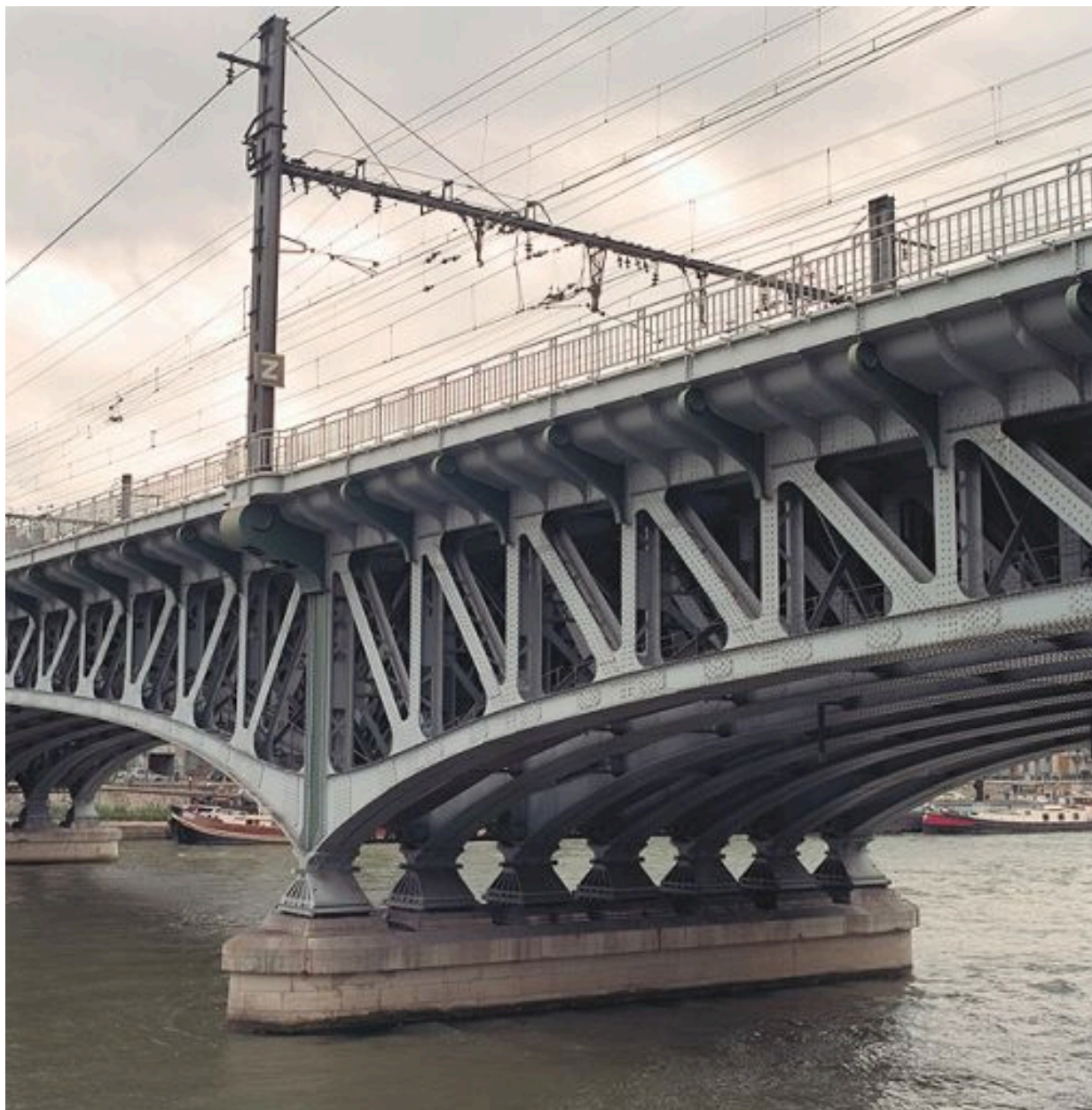
Détail d'une pile depuis le rive droite de la Saône
