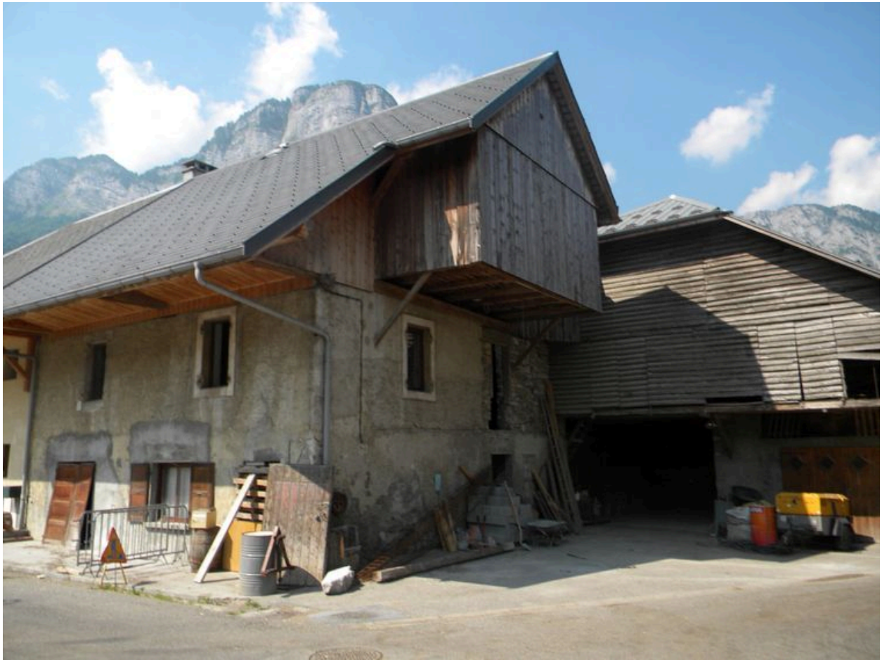
Vue d'une ancienne ferme équipée d'un monte-foin sur le pignon (2008 A2 193).
