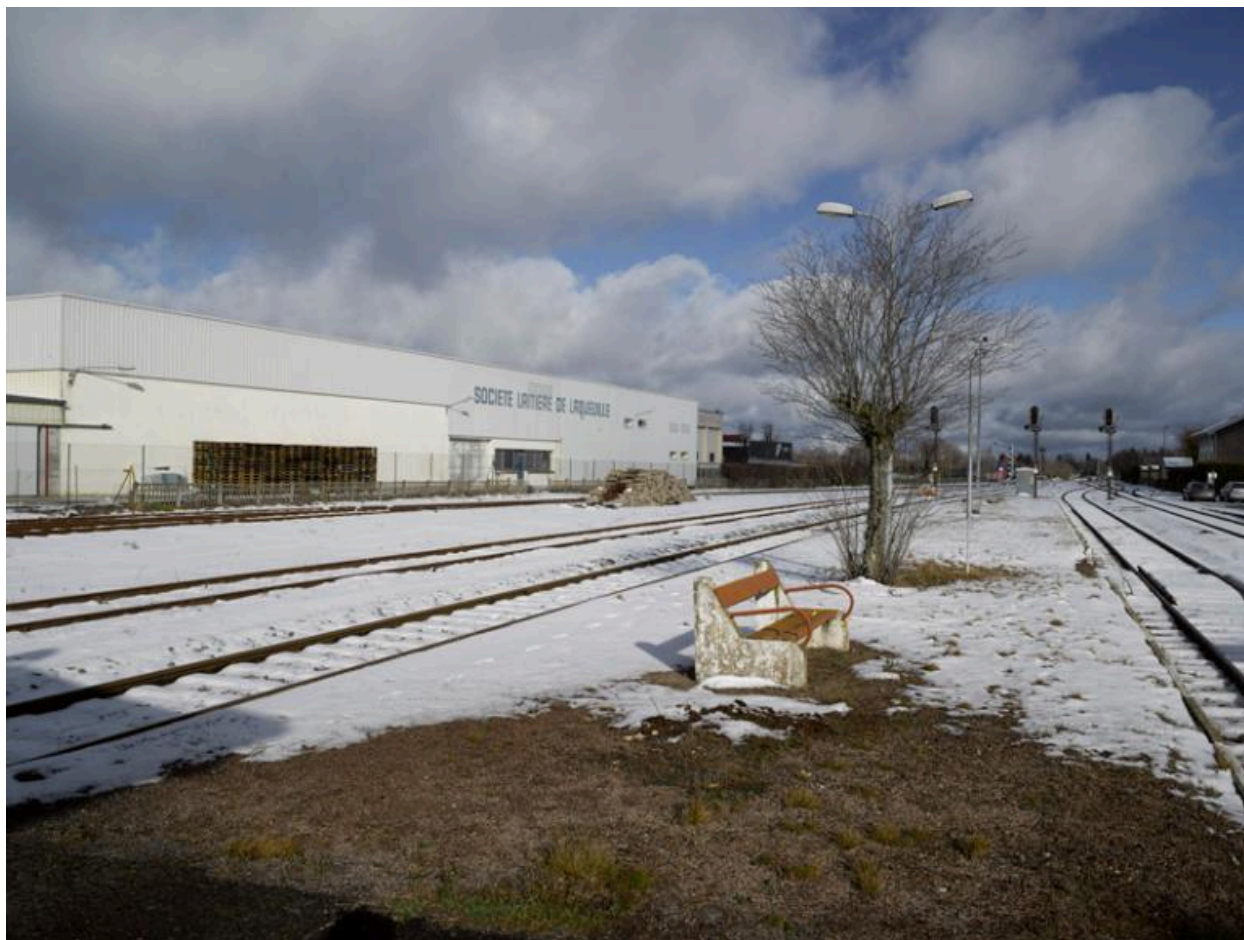
La laiterie-fromagerie de Laqueuille (société laitière de Laqueuille), depuis l'un des quais de la gare.
