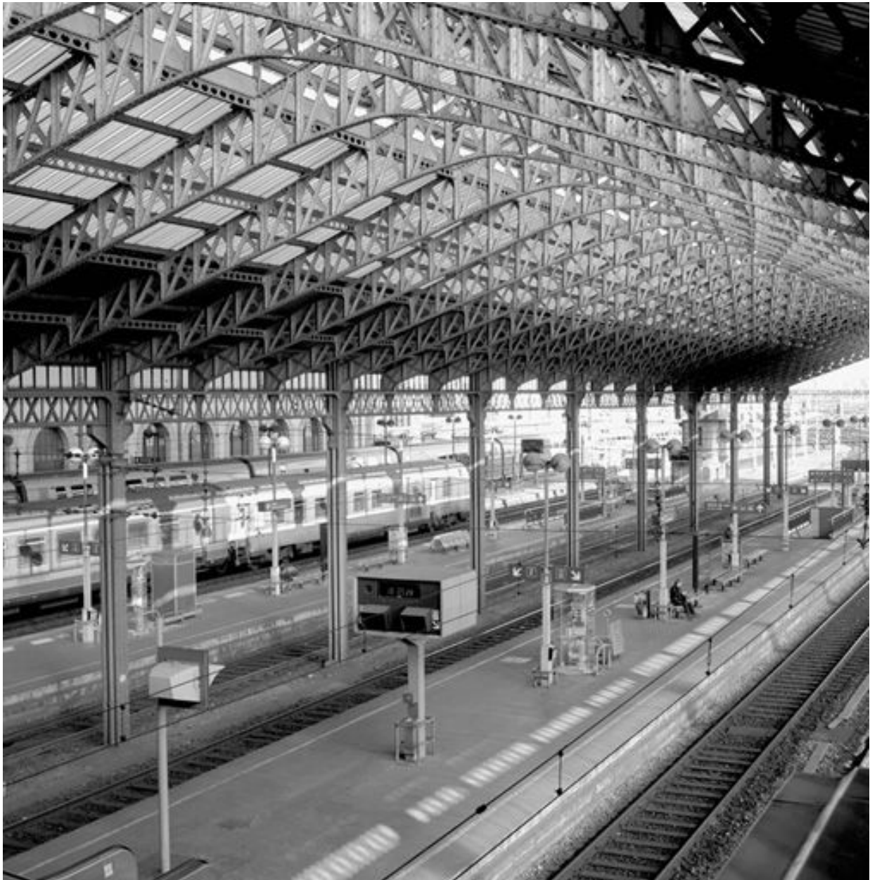
Halle Saint-Etienne : la charpente métallique
