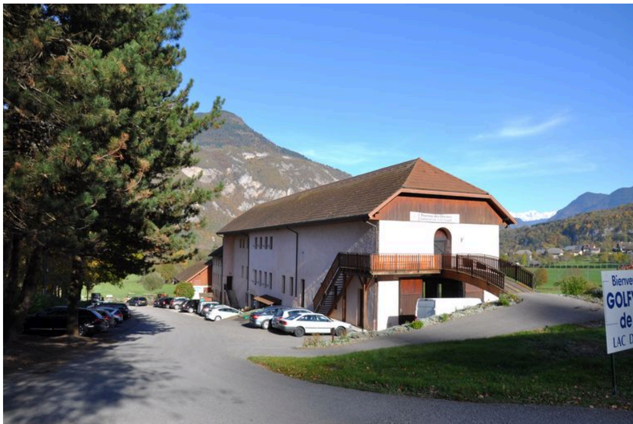
Elévation sud-ouest de l'ancien bâtiment d'usine
