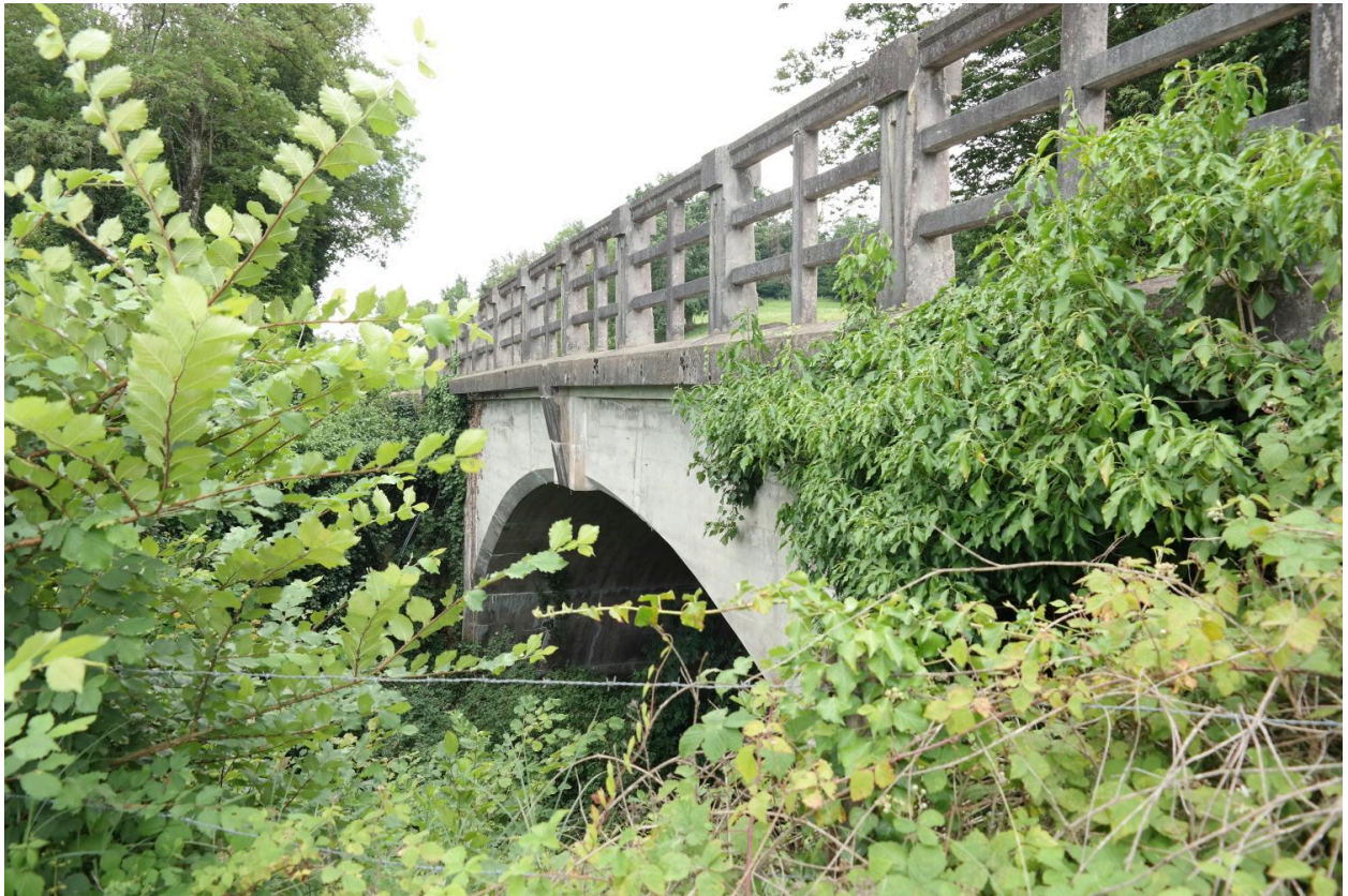
Pont Borian, vue de la face aval
