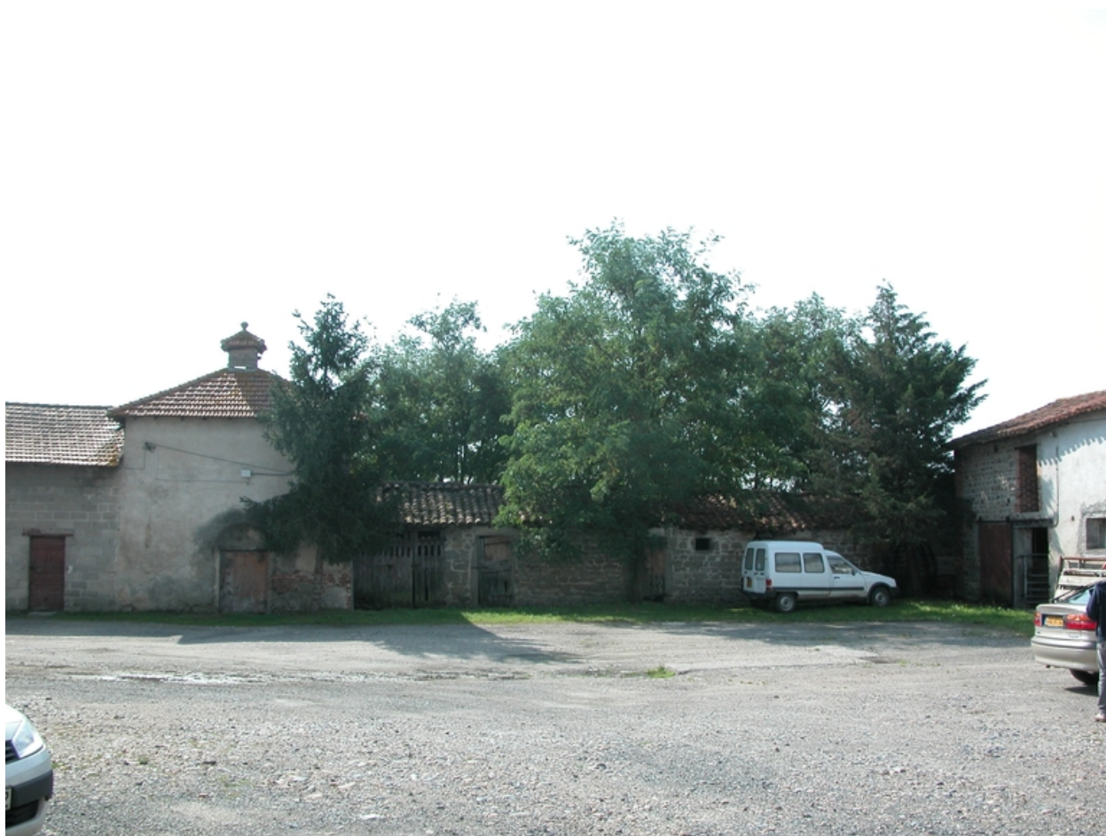
Vue d'ensemble de l'angle sud-ouest de la cour, depuis l'est.
