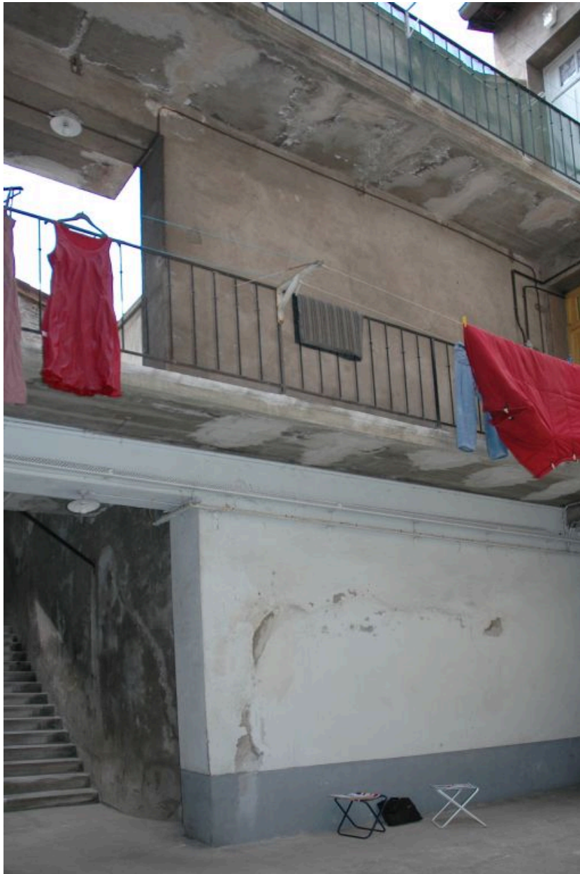
Balcon-galerie sur cour.
