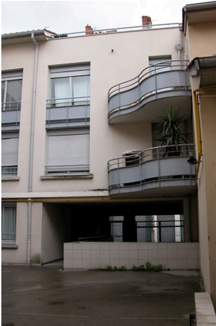
Elévation postérieure, rue Chalopin
