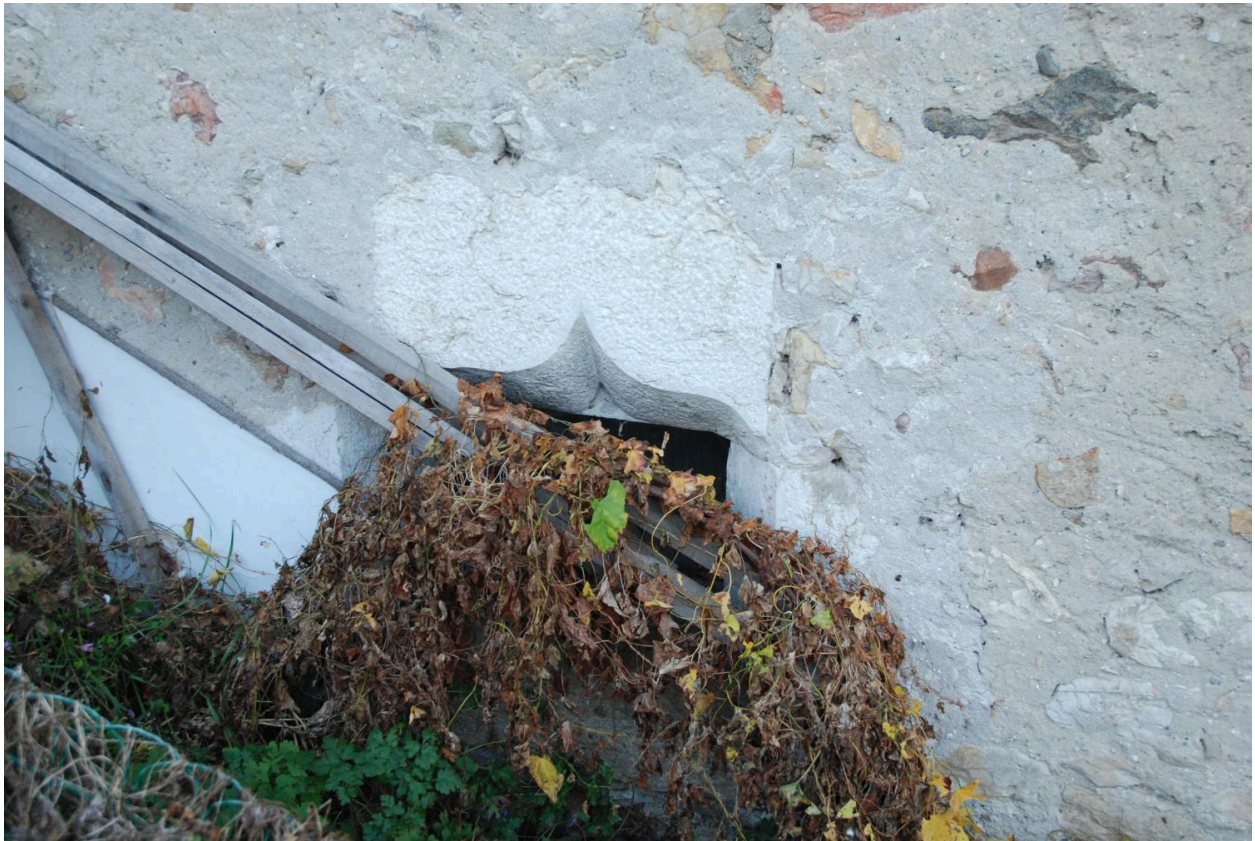
Vue arrière, détail de jour à linteau en arc infléchi.
