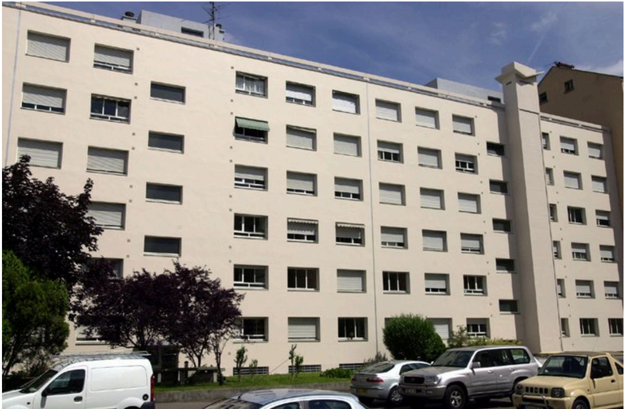
Elévations postérieures des bâtiments de la rue Louis-Dansard
