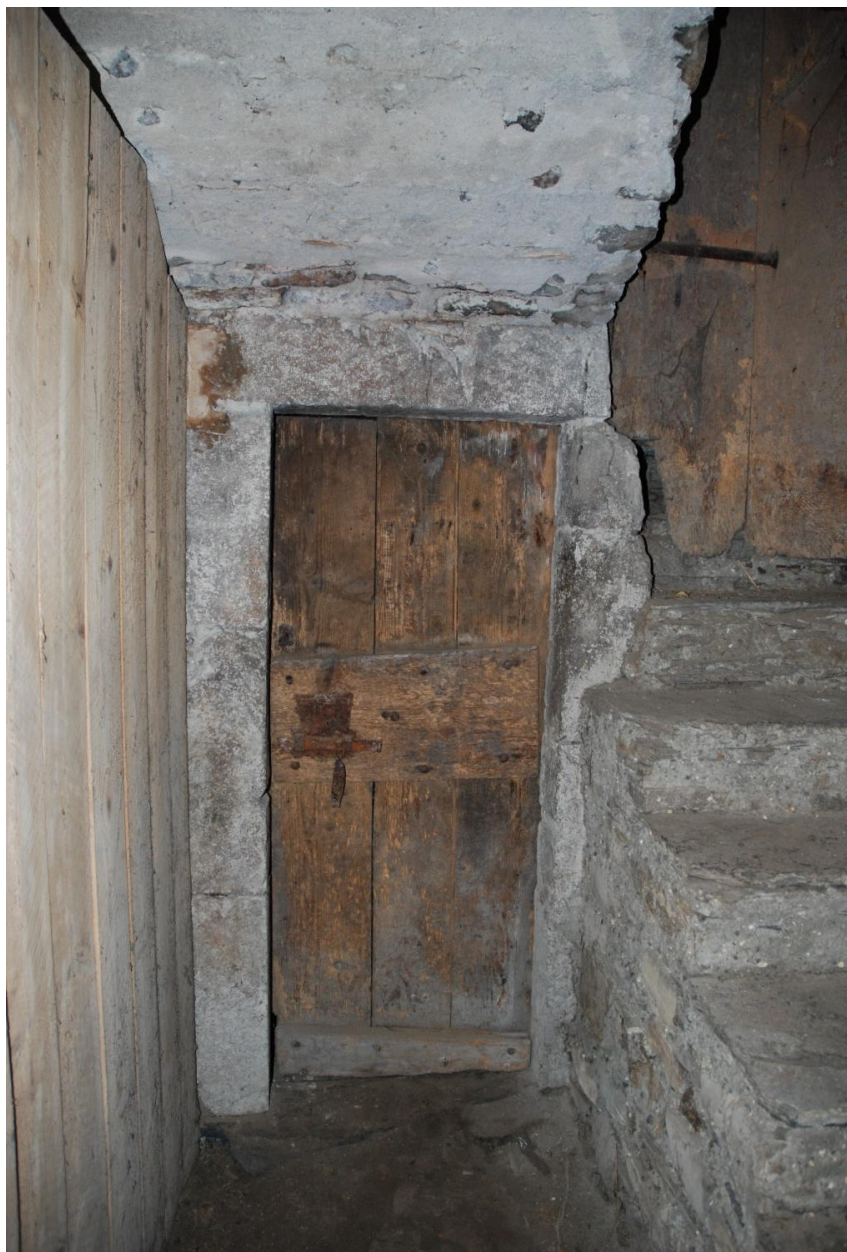
Vue intérieure de la cave : porte d'un cavon à côté de l'escalier.
