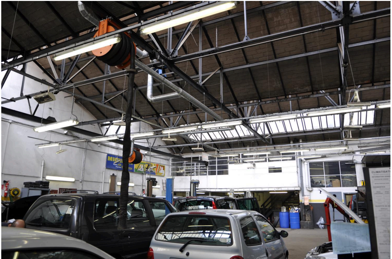
Vue intérieure, garage à charpente métallique
