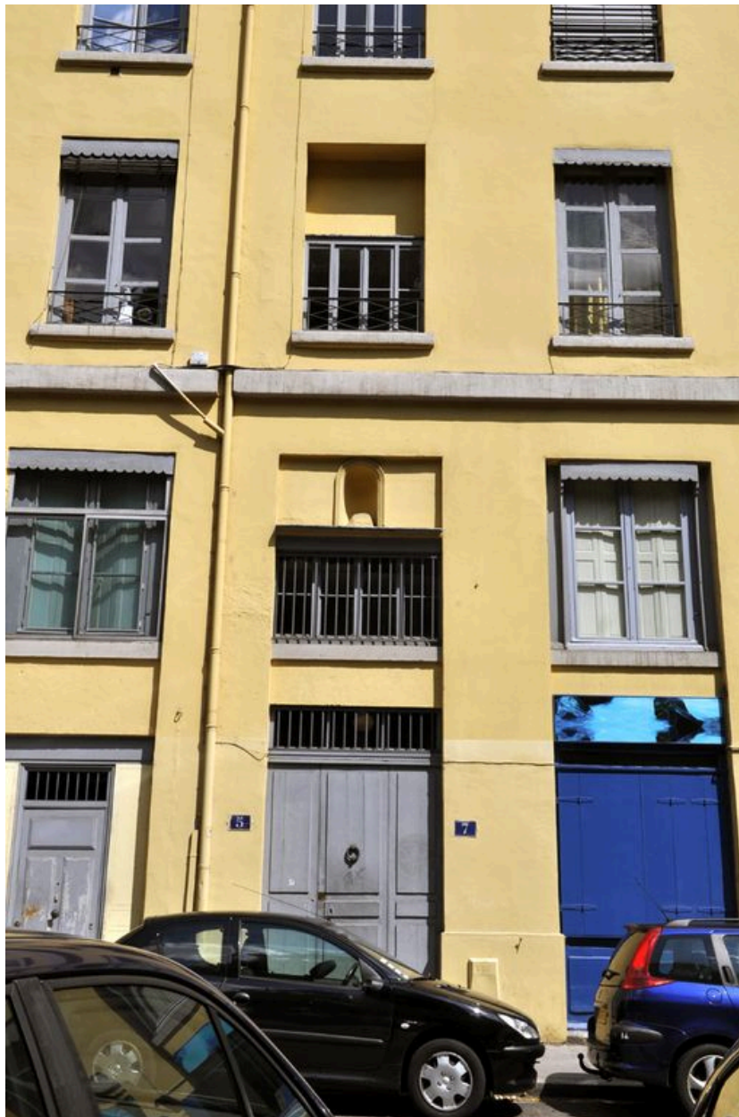
Détail de la façade rue Tramassac
