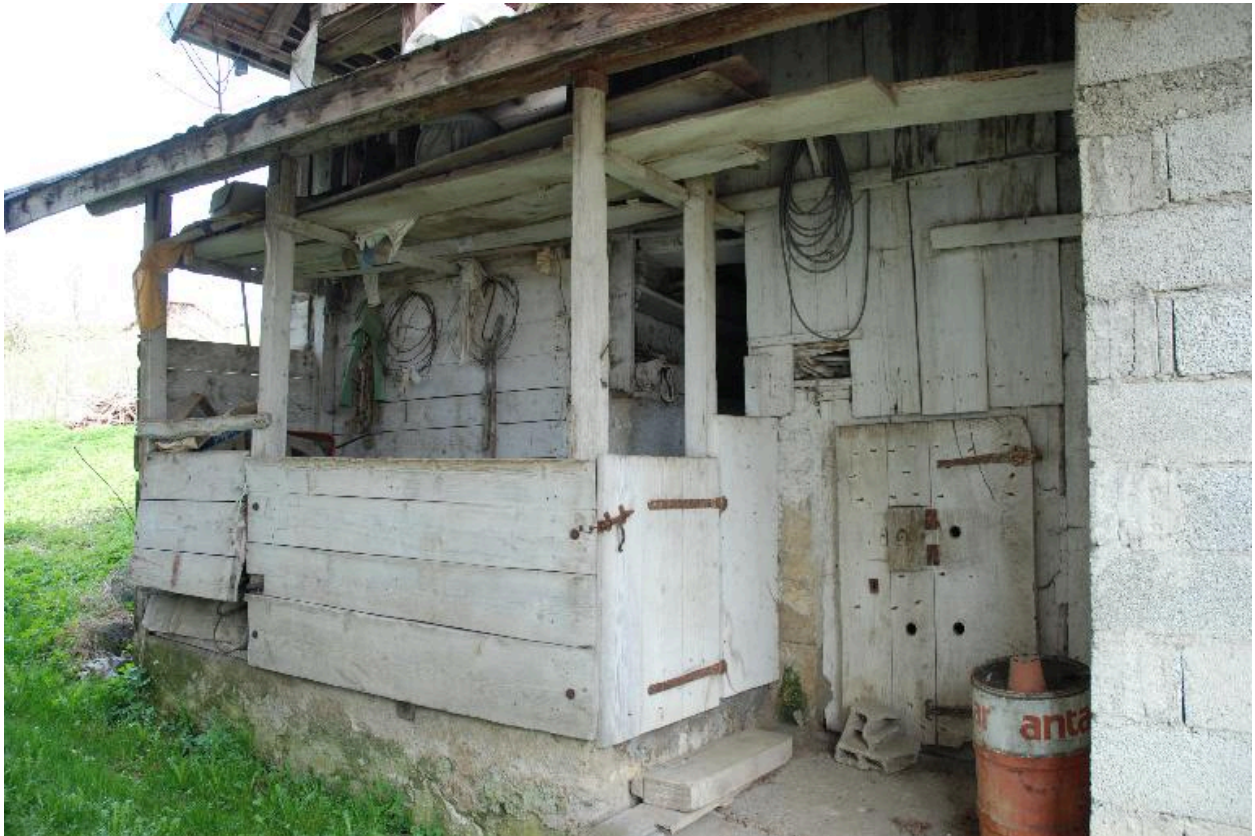
Vue de la dépendance : élévation ouest.
