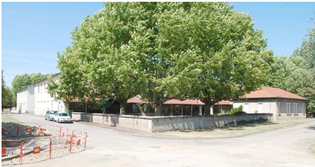
Bâtiment 456-457, vue d'ensemble depuis le sud-est
