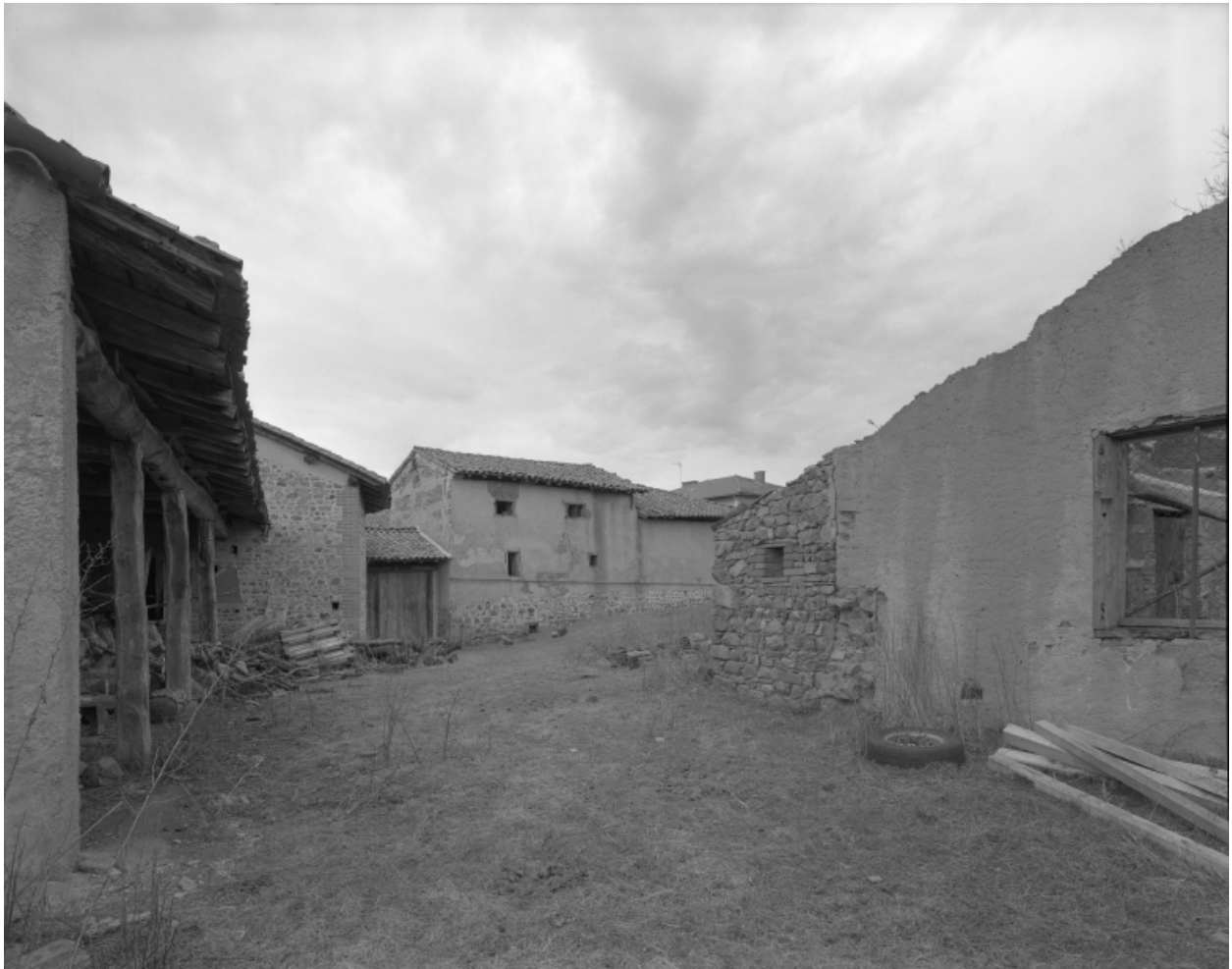
Vue d'ensemble des bâtiments depuis l'ouest : élévations postérieures du logis à galerie et du cuvage. A gauche, mur de la forge.
