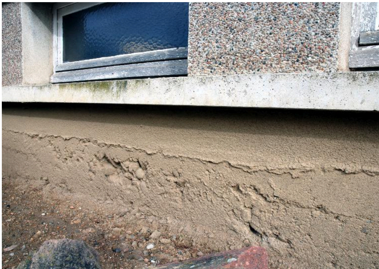
Bâtiment HI : élévation sud, détail du soubassement
