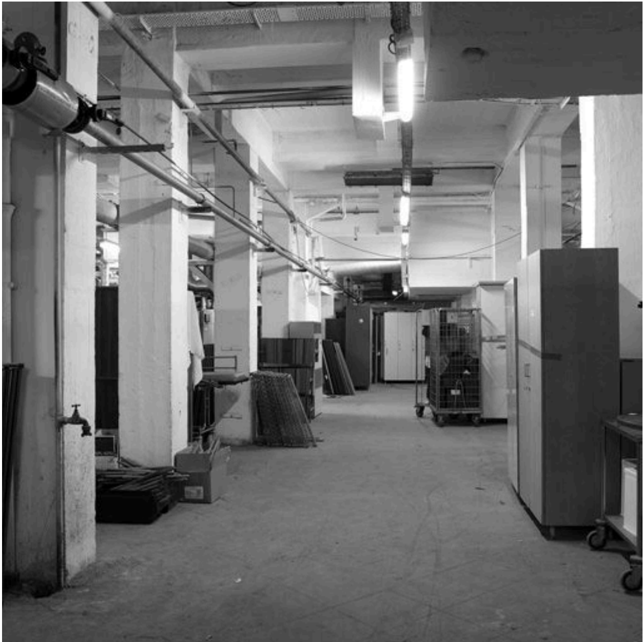
Rez-de-chaussée : les piliers en béton
