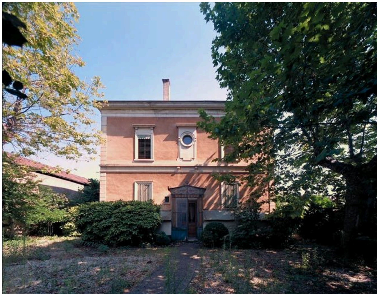
Elévation postérieure donnant sur la rue Joannès-Carret
