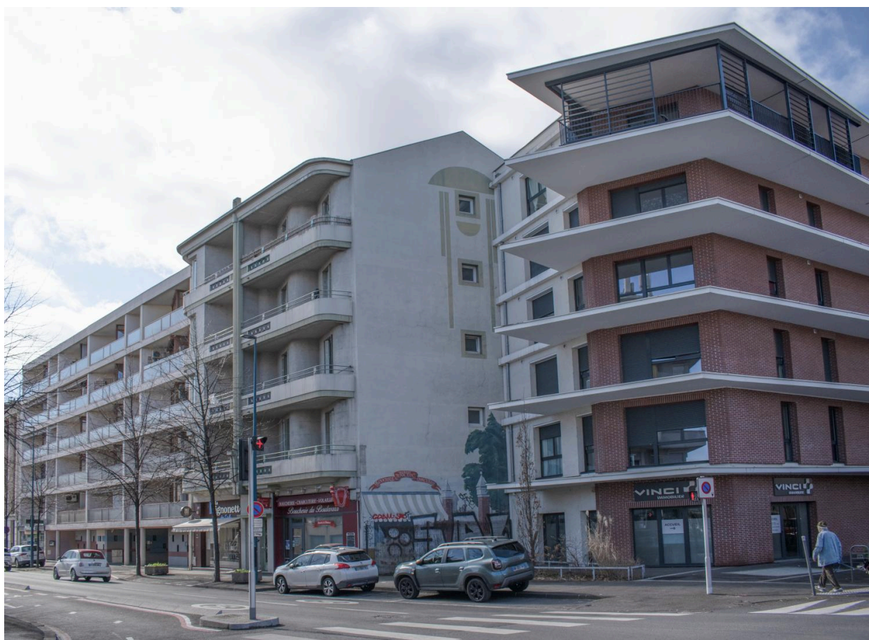
Façades sur le boulevard Aristide-Briand
