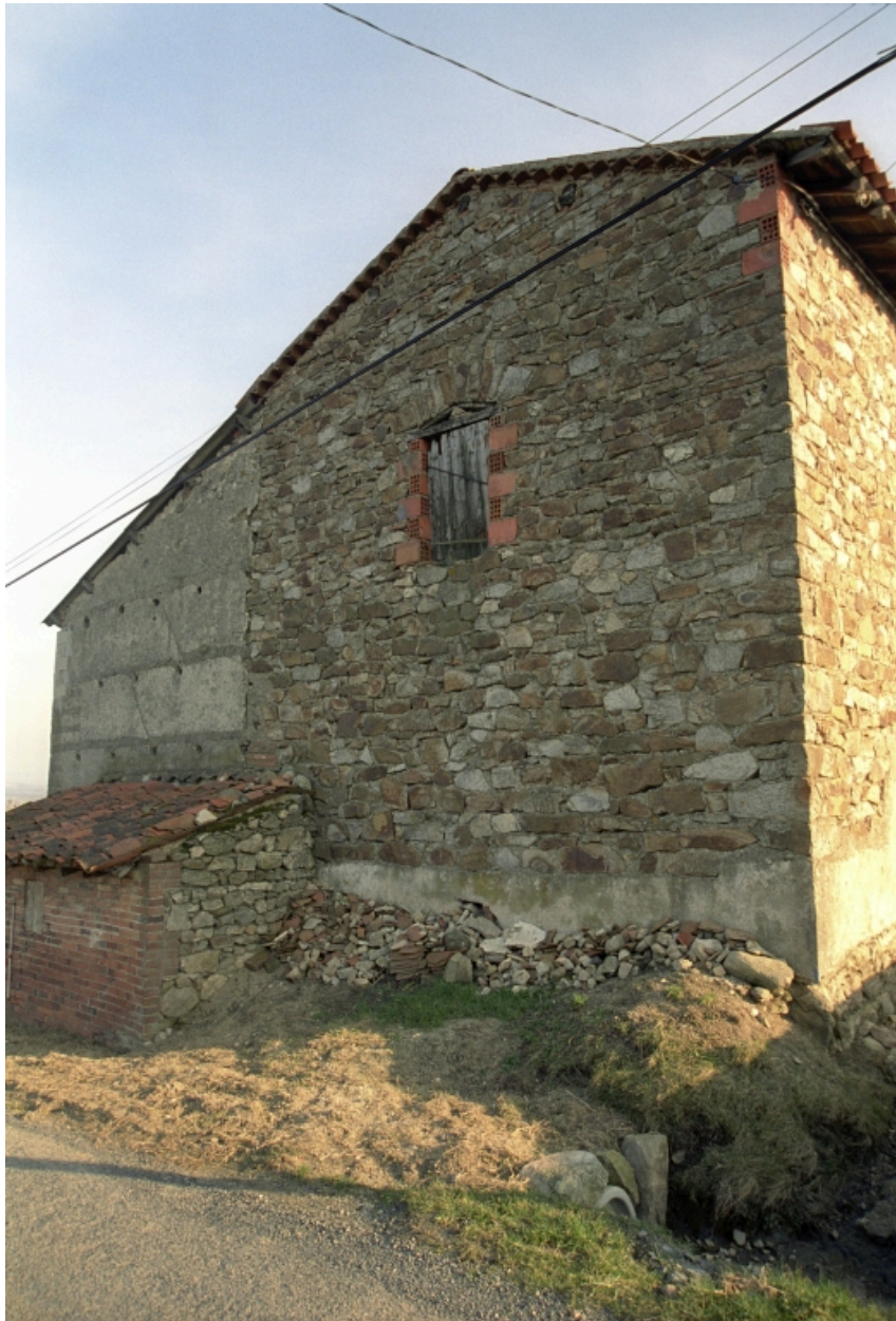
Pralong, Menacey, ferme (1987 A1 582). Mur en moellon de granite.
