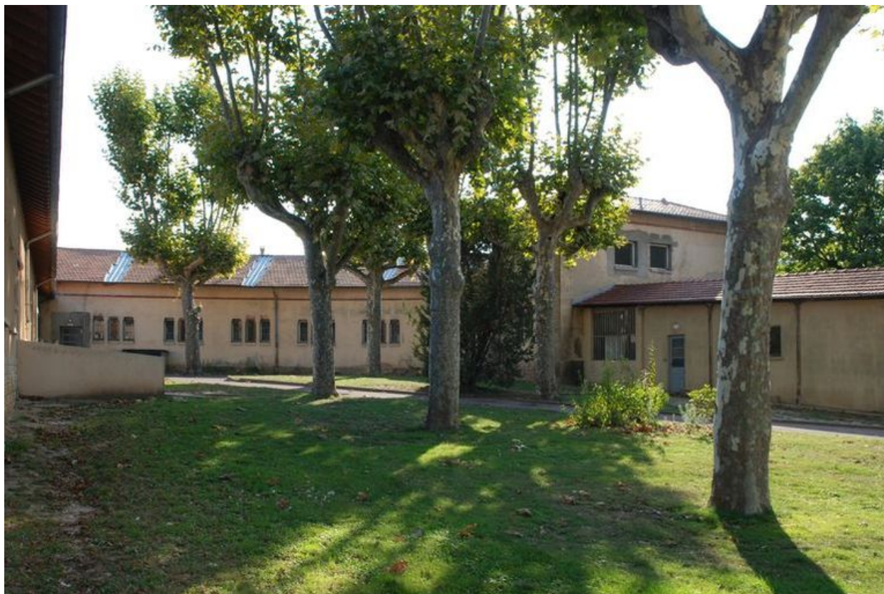
Ancien bâtiment des agités, dit 3e division bis, actuellement bâtiment 332-333. Vue depuis le nord
