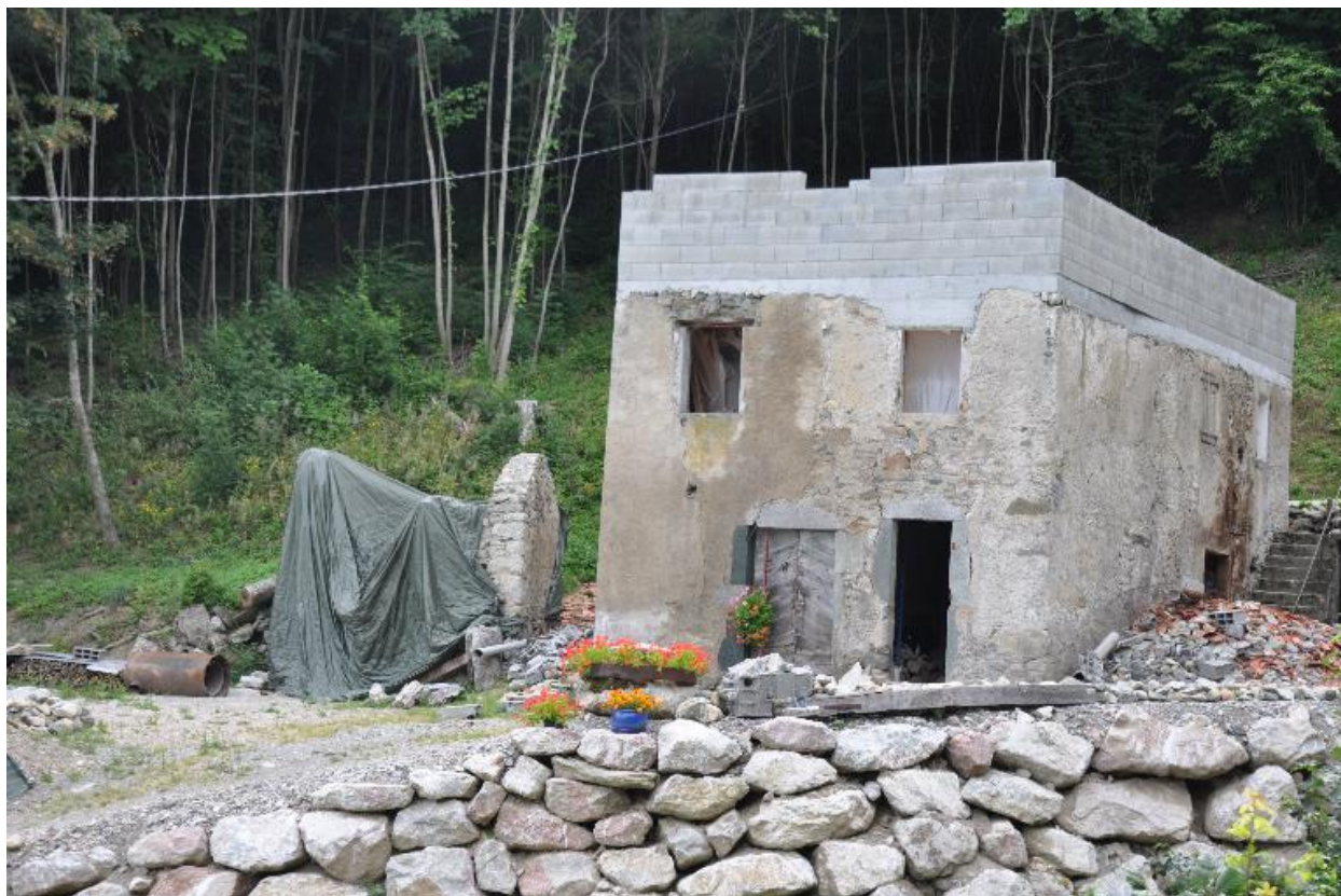
Détail de la façade antérieure du moulin situé plus en aval
