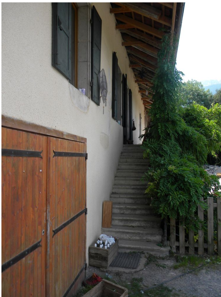
Vue de la volée d'escalier menant au logis.
