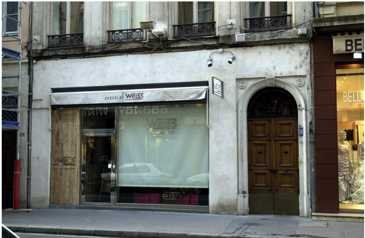
Elévation antérieure : le rez-de-chaussée
