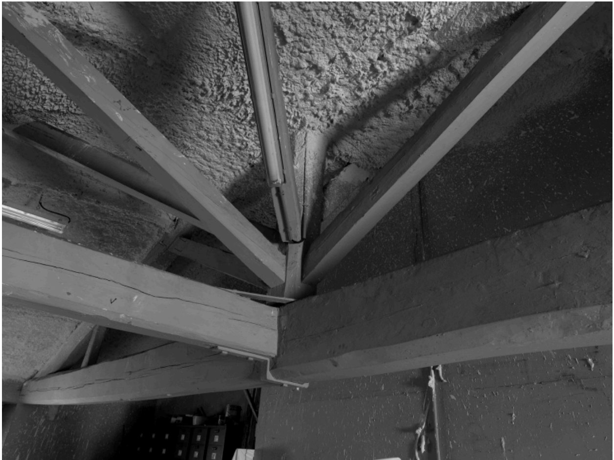
Bâtiment L. Etage de comble. Détail de la charpente
