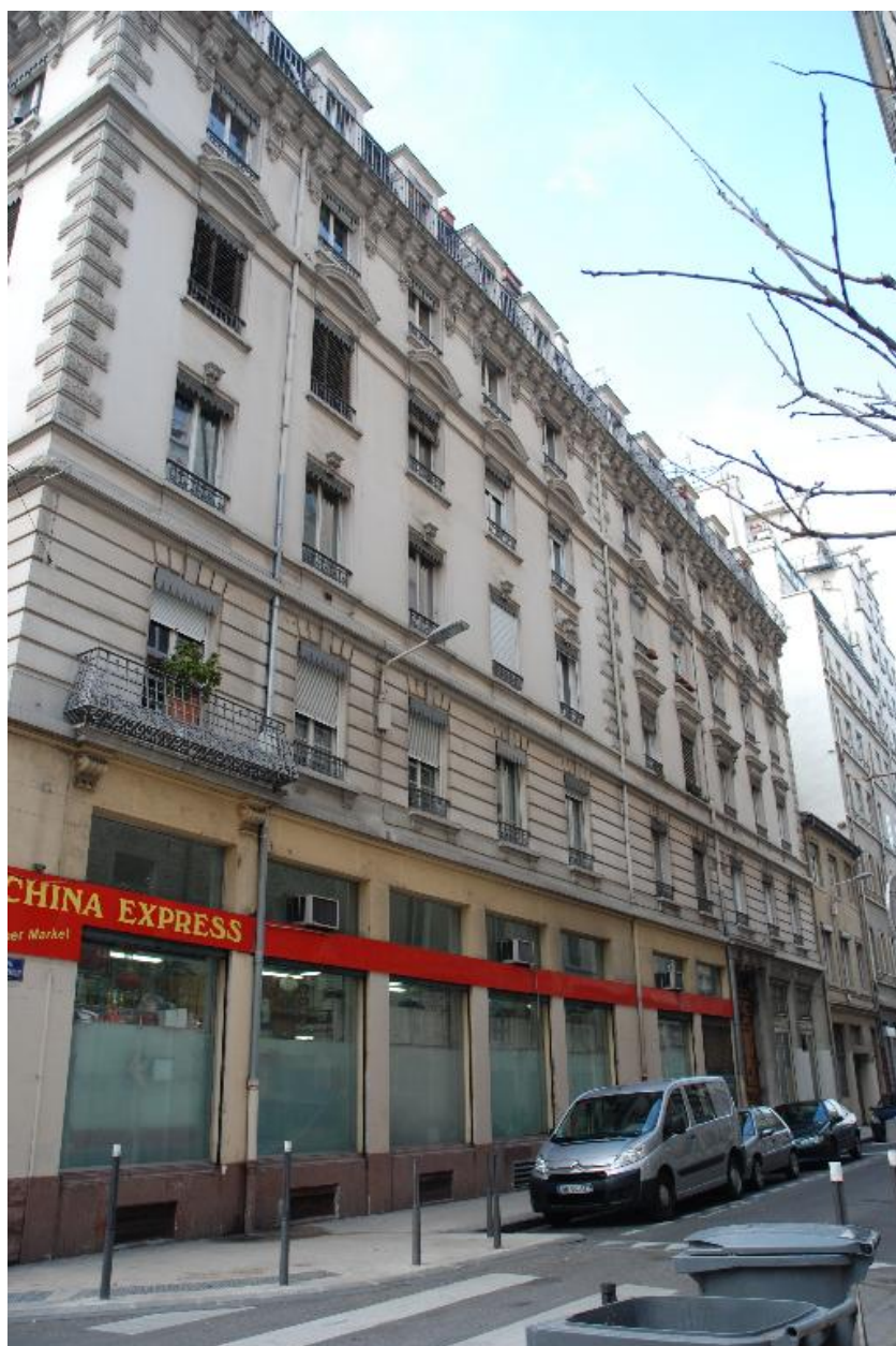
Vue générale de l'élévation sur rue
