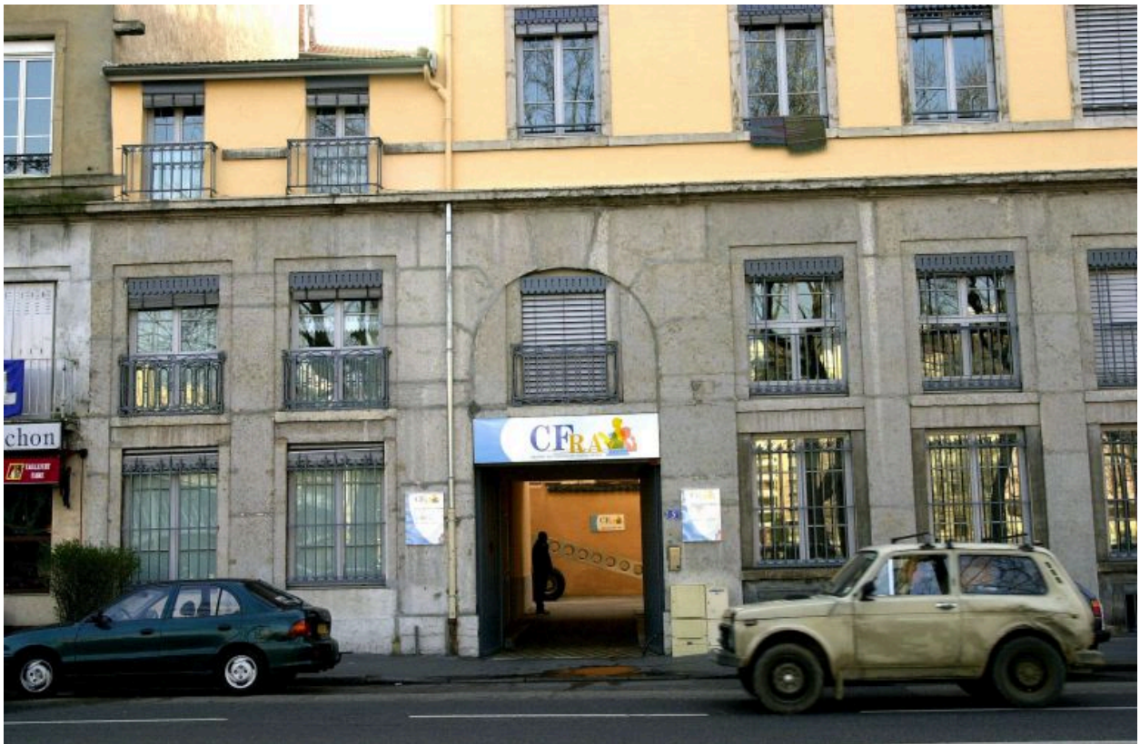
Vue du passage couvert, quai Rambaud
