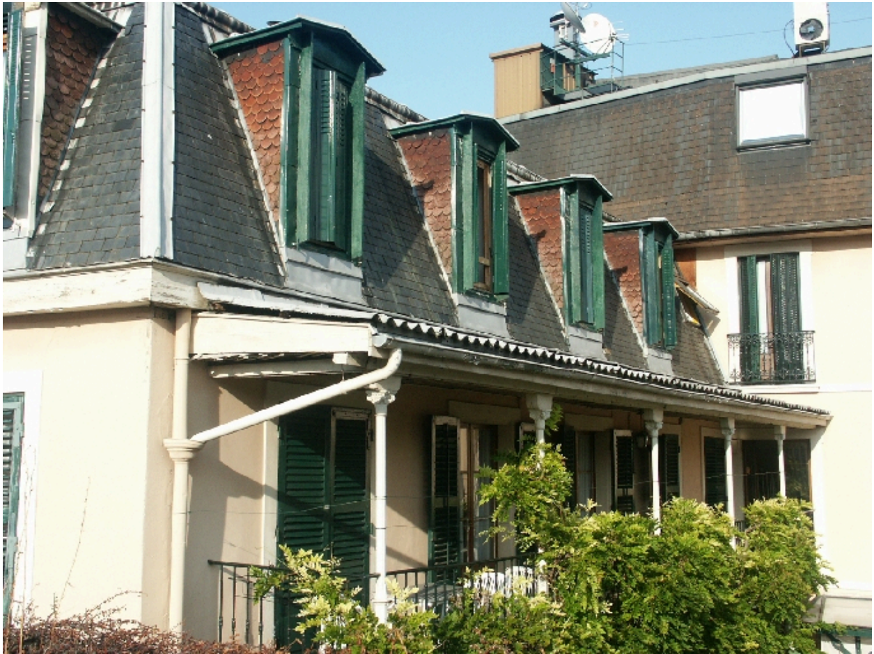
Détail des toitures
