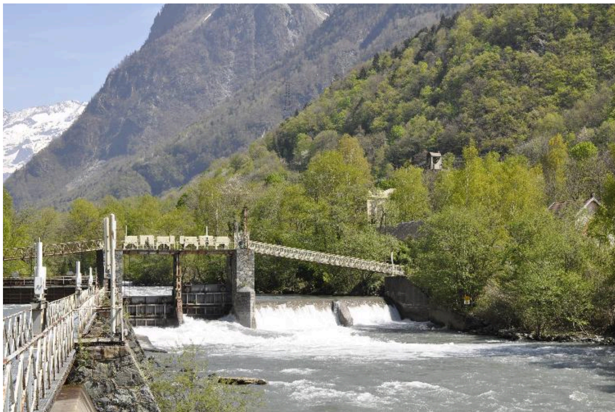
Vue du barrage
