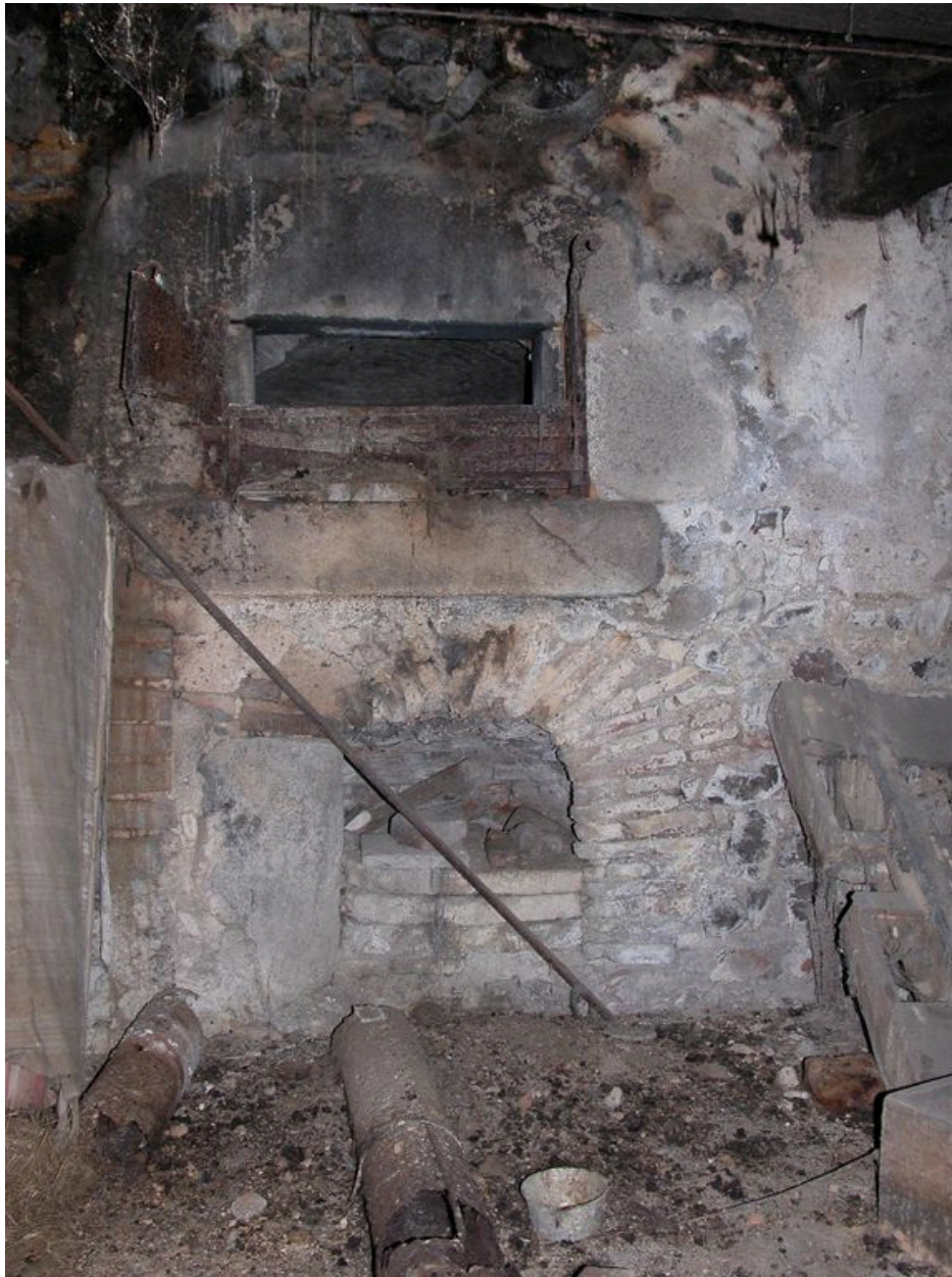
Détail du four à pain.
