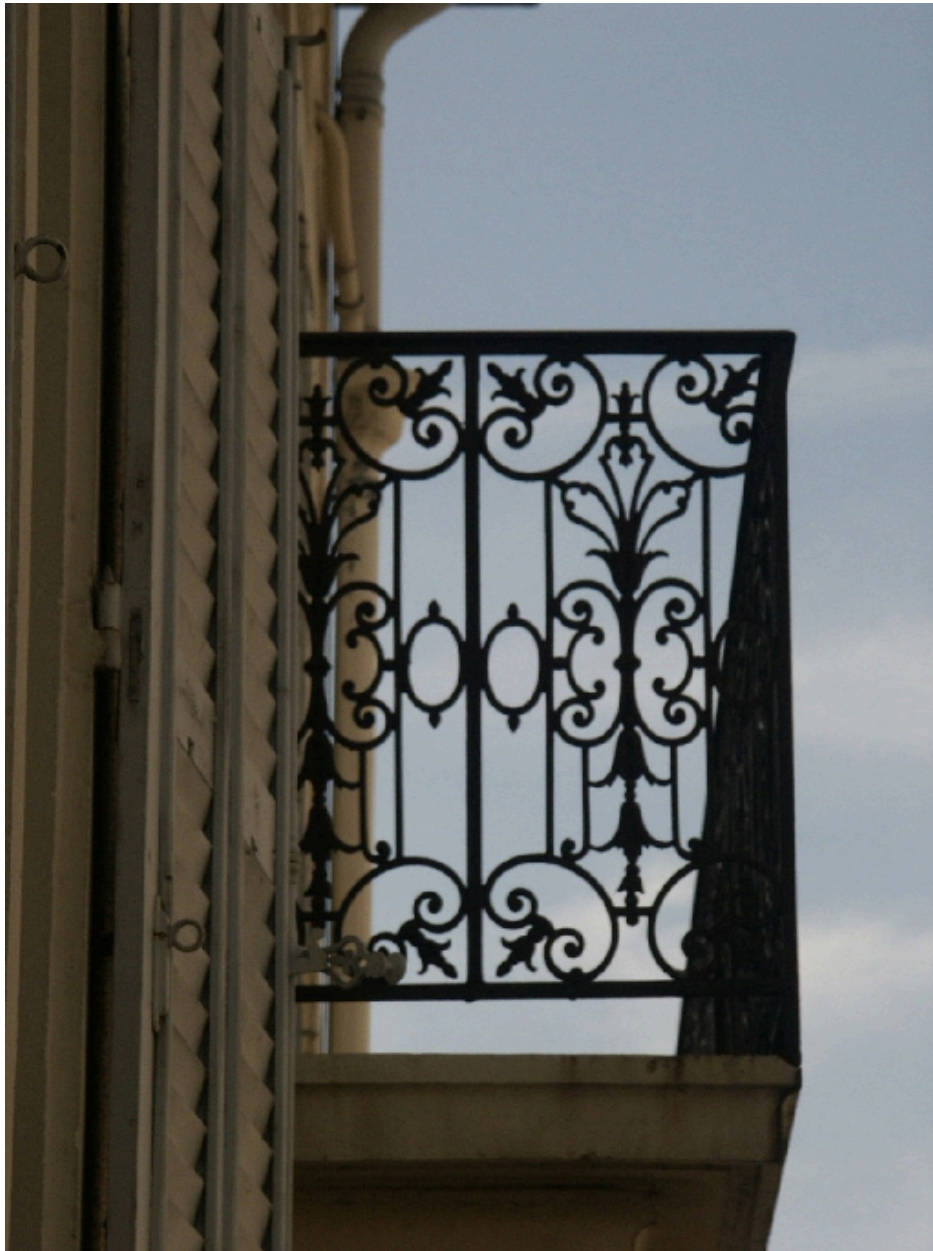
Détail de ferronnerie d'un balcon sur rue
