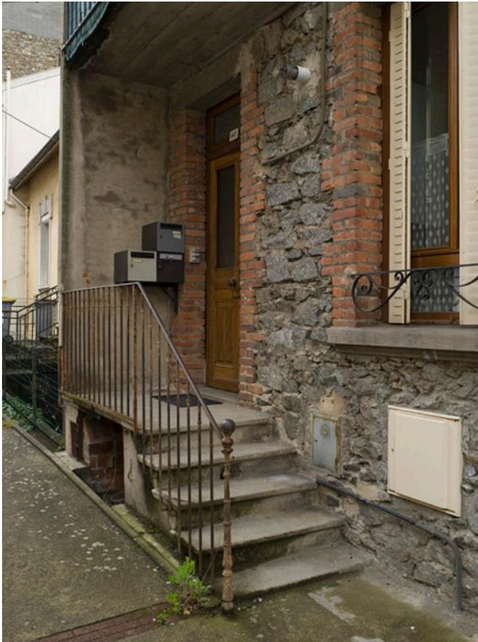
Accès à un rez-de-chaussée surélevé d'une maison de l'avenue.
